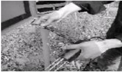
将控制器土壤湿度传感器的防水接头从箱体的出现口穿出, 并和传感器接头连接, 旋紧防水接头
