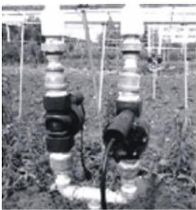
在管网中安装好电磁阀, 气候寒冷的地方, 注意做好防冻保护
